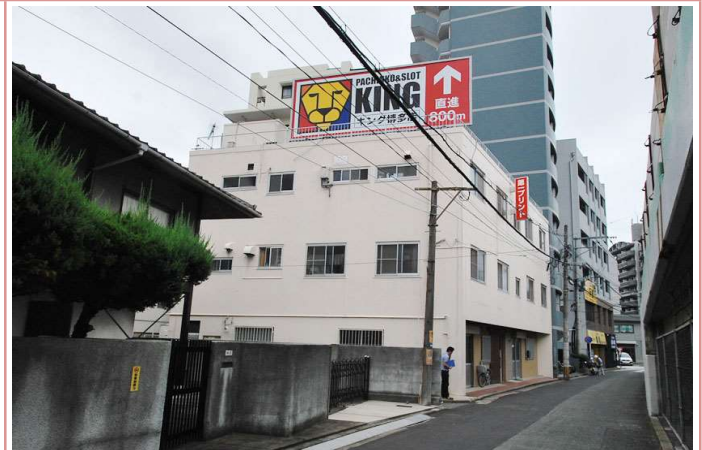
外壁改修完了
