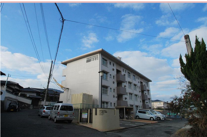
外壁改修完了です！(2014/1)
