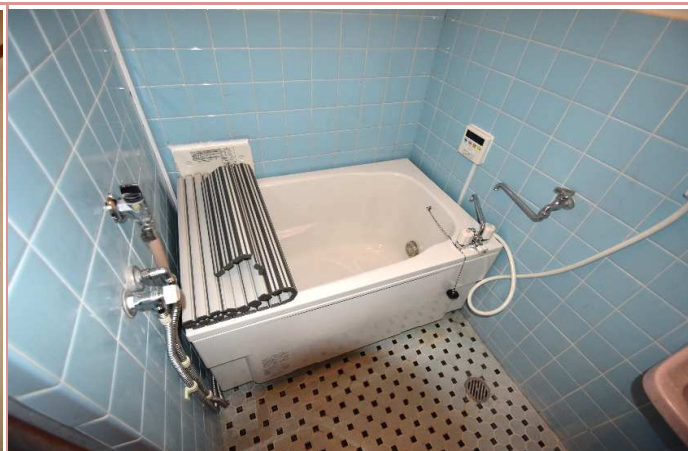
浴室 バランス釜から給湯を新設しました☆
