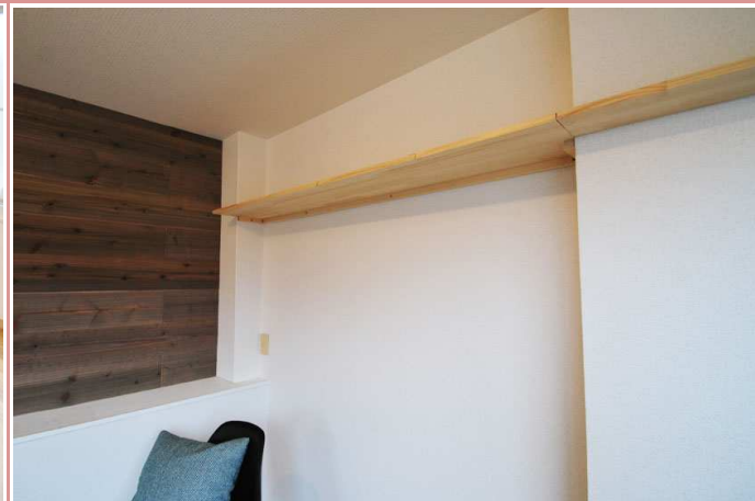
リビング 上部棚を設置(^-^)
