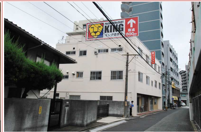
外壁改修完了☆
