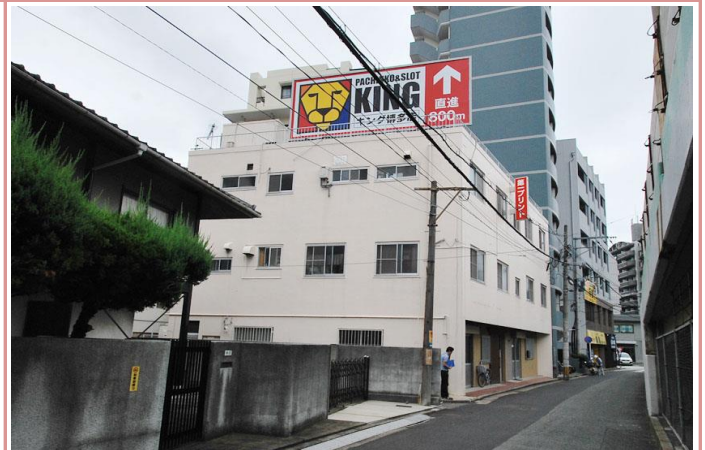
外壁改修完了
